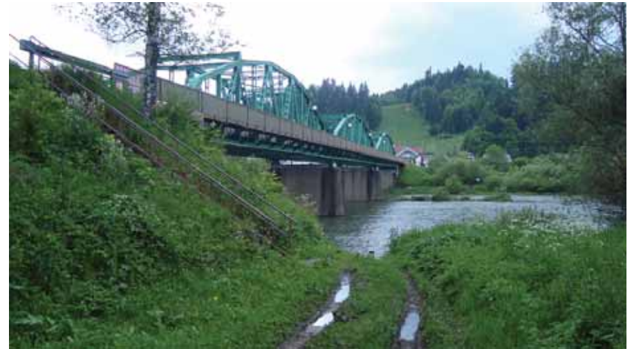
Sprawca zamieszania: most w Huzelach i schodząca do Sanu „przeprawowa” droga, stan z 2010 r. Fot. A. Wesół
